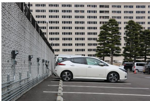
「別府温泉 杉乃井ホテル」充電コンセント付き駐車場
